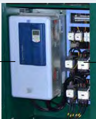
ARRANCADOR ESTRELLA - TRIÁNGULO
