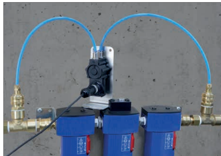
Típico lugar de uso para la medición de la presión diferencial en combinación con dos mangueras PE delante y detrás de los elementos filtrantes.
